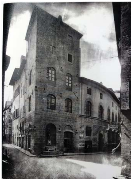
Fig. 11 - La torre all'angolo tra Borgo San Jacopo e Via Guicciardini, nelle immediate adiacenze di Ponte Vecchio a Firenze.
